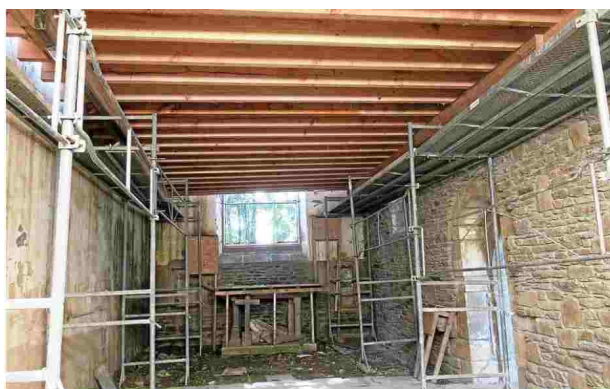
Le mur défectueux de la chapelle Ar Hoat a été refait à l'identique par Philippe Trémour. La charpente, elle, est en cours d'assemblage par Franck Le Page.
