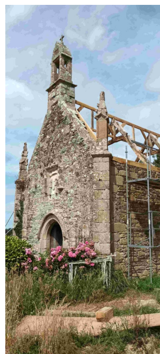
Le mur défectueux de la chapelle Ar Hoat a été refait à l'identique par Philippe Trémour. La charpente, elle, est en cours d'assemblage par Franck Le Page.
