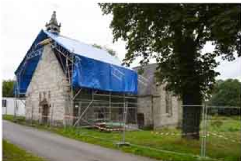
Mise en place du parapluie et de la clôture du chantier
